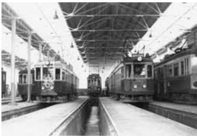
Interieur grote remise met A617/628-A509-A603/604 2 oktober 1950 Foto J.C.T. van Engelen
