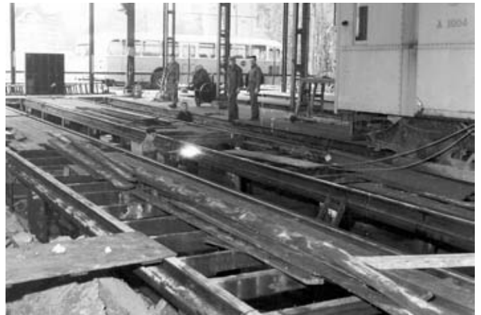
A1004 ombouw remise Leiden Rijnsburgerweg, 9 oktober 1960. Foto D. van der Spek
