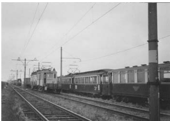
Allemansgeest na aankomst van het laatste konvooi met sloopmaterieel, de sloop kan beginnen; 13 november 1961. Foto: L.J.P. Albers
