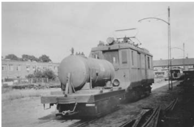
De A1004 + H108 op het werkspoor A naast de remise Soendaplein, 1947. Op de achtergrond is nog een bijwagen serie B41-43 te zien die gesloopt wordt.
